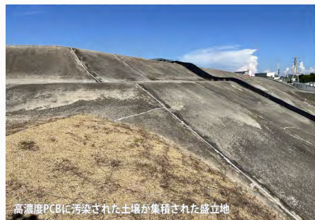
高濃度PCBに汚染された土壌が集積された盛立地
