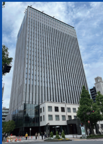
新庁舎は、震災対応にも優れ、大規模災害時にも市民への情報発信、生活再建・復興の中核拠点として役割を担います。
